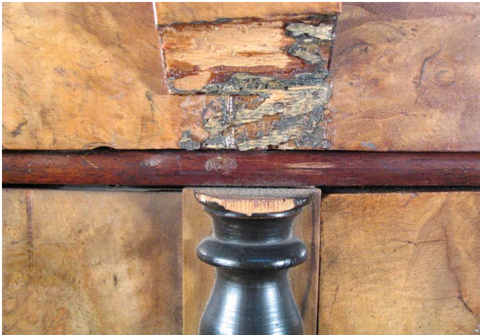
Abb. 4: Heraus gebrochene Fehlstelle an Bogen und Säule
